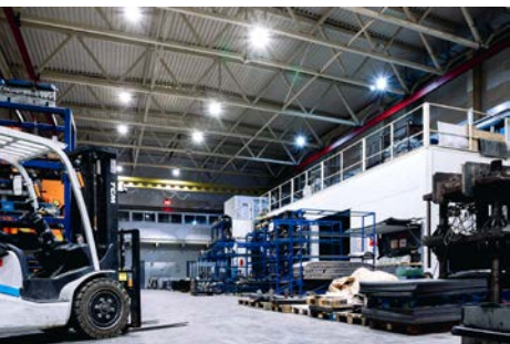
ПРОМЫШЛЕННОЕ И СКЛАДСКОЕ ОСВЕЩЕНИЕ
